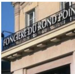
Devant les garde-corps, les auvents et marquises, les enseignes doivent être réalisées au moyen de lettres ou de signes découpés et sans panneau de fond. Elles ne doivent pas dépasser la limite haute du garde-corps et présenter une saillie supérieure à 0,25 m par rapport à celui-ci, ni dépasser une hauteur d'1 m sur les auvents et marquises.
