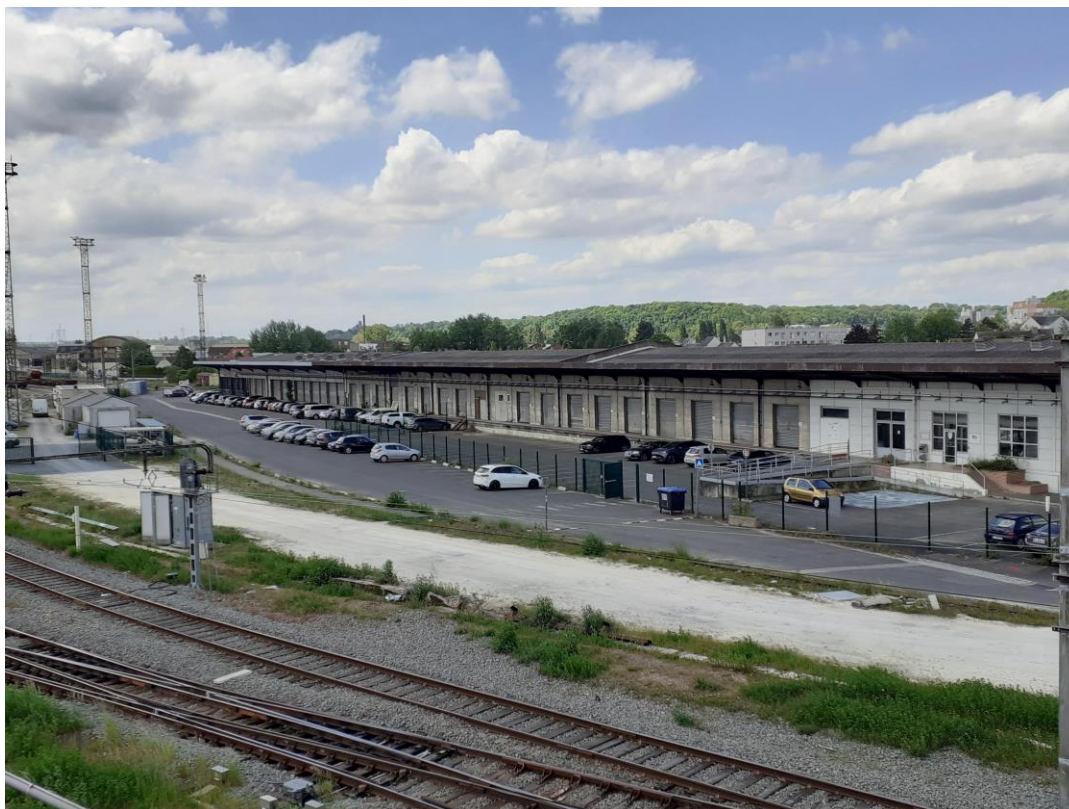
Photo prise depuis le pont de la Rue Gambetta (N°2 sur la carte)
