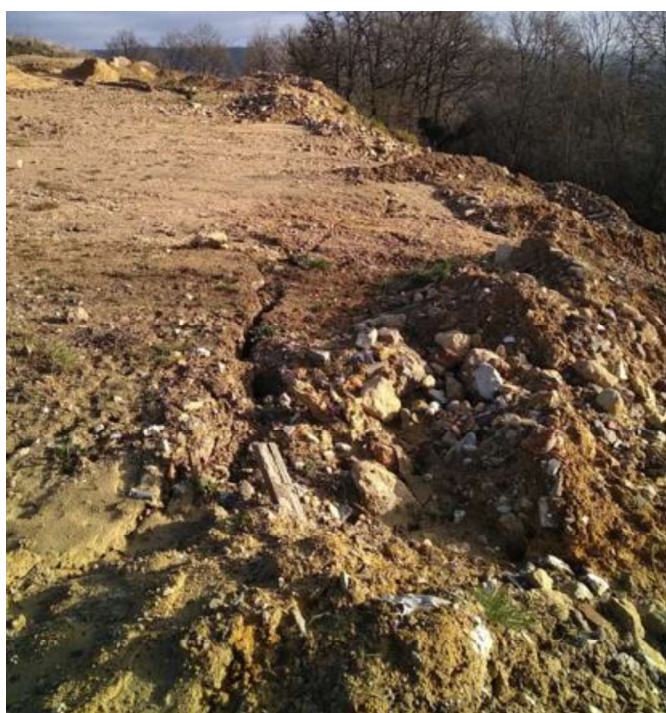
Cicatrice d'arrachement sur le Talus Sud, partie Sud (photo du 26/02/2025)
