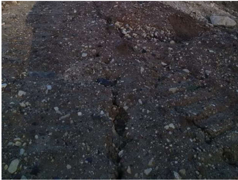
Cicatrice d'arrachement sur le Talus Nord, partie Sud-Est (photo du 26/02/2025)
