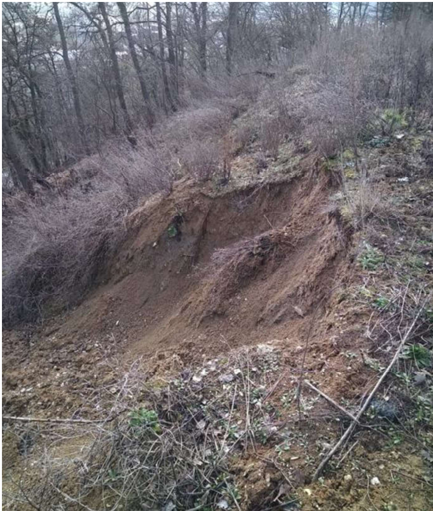
Effondrement sur le Talus Sud, partie Nord (photo du 26/02/2025)
