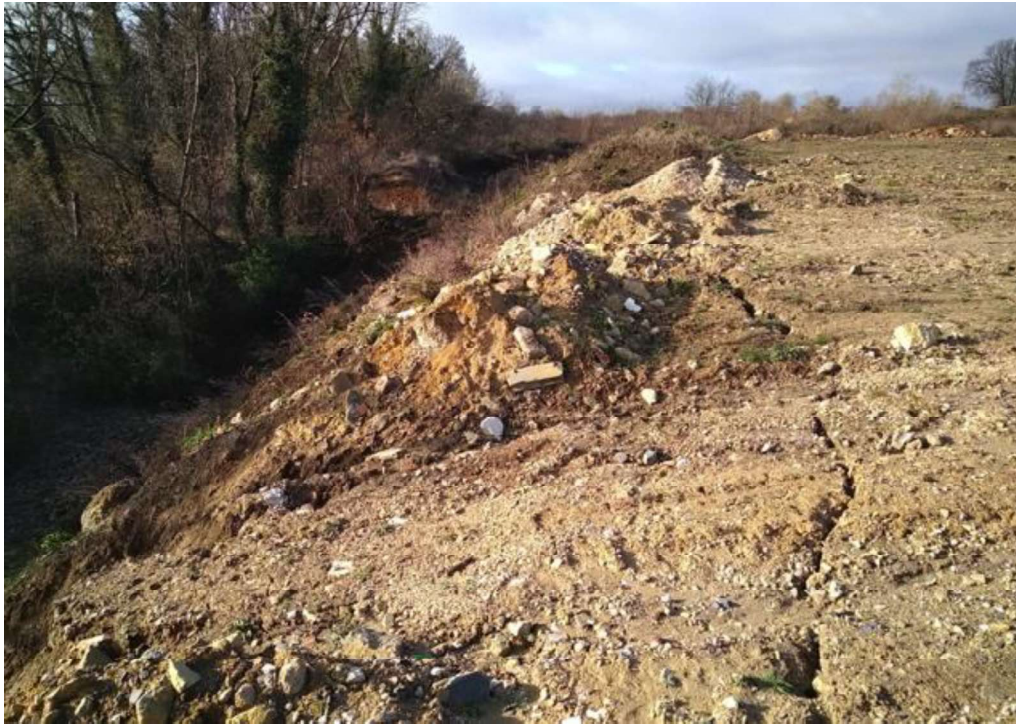
Cicatrice d'arrachement sur le Talus Sud, partie Sud (photo du 26/02/2025)
