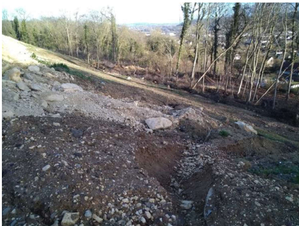
Vue de marques de ruissellement /ravinement sur le Talus Nord, partie Sud-Est (photo du 26/02/2025)
