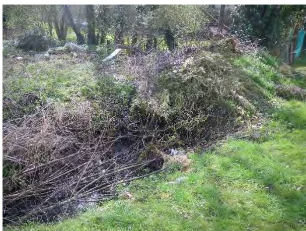
Photo 7: Fossé de contournement de la D200 et D1016
