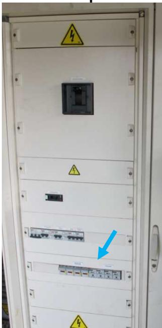
Cette armoire est déjà munie de parafoudre de type I. Il s'agit de parafoudre Indelec type I DGV400/4 de caractéristiques  $U_c$  400v /  $U_p$  1.5kV /  $I_{imp}$  15kA /  $I_n$  20kA.
