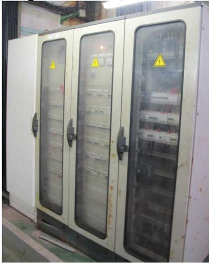
Cette armoire est munie de parafoudre de type II. Il s'agit de parafoudre Indelec type II DGT400/4 de caractéristiques  $U_c$  440v /  $U_p$  1.8kV /  $I_{max}$  40kA /  $I_n$  10kA. Deux cartouches de ce parafoudre sont percutees.
